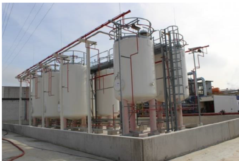
afbeelding 16 illustratie tank-pit (voorbeeld). Bij Wubben Noord B.V. worden de tanks onder een overkapping geplaatst
